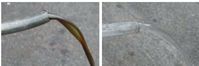
Zanieczyszczony układ chłodzenia podczas płukania (po lewej) oraz czysty układ chłodzenia po zakończonym procesie płukania (po prawej)
